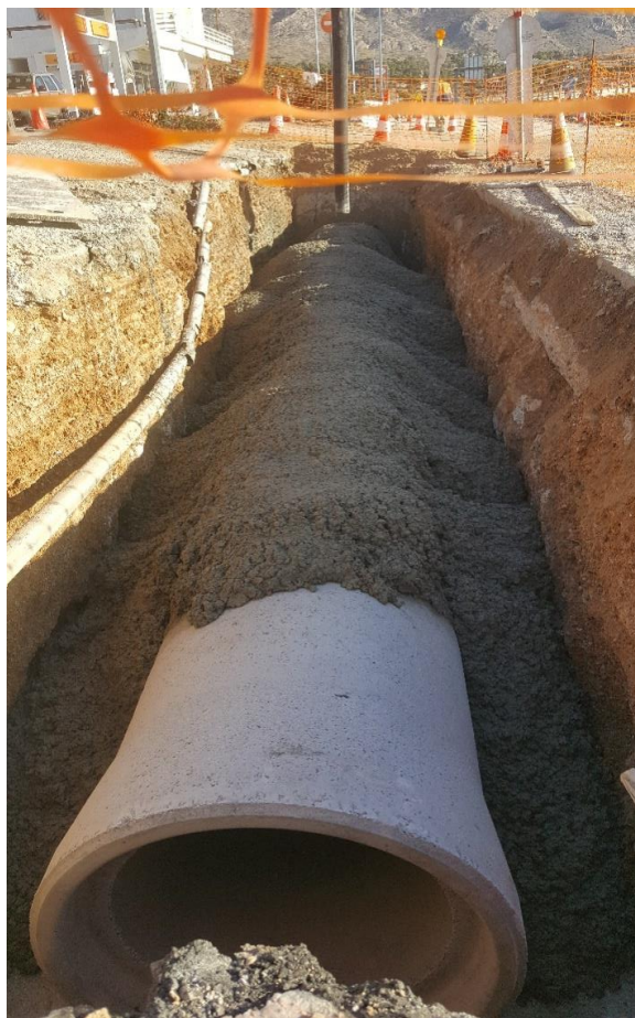
Κατασκευή δύο αγωγών αποστράγγισης Φ800 (κρ: 55+200)
