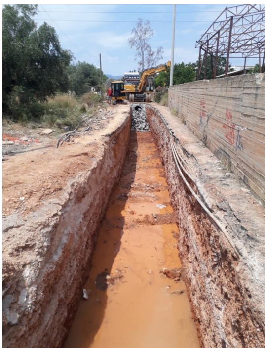
Αντιπλημμυρικά έργα σε τμήμα ΕΛΚΟ Κόμβος Θηβών
