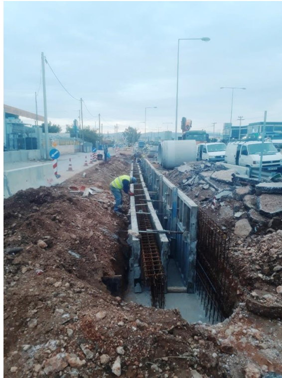
Αντιπλημμυρικά έργα στον κόμβο Θηβών
