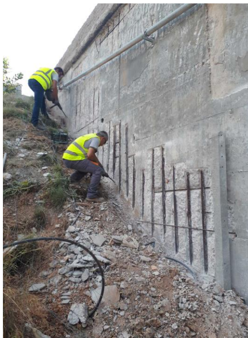
Κατασκευαστικές εργασίες σε υφιστάμενο τεχνικό Κ002
