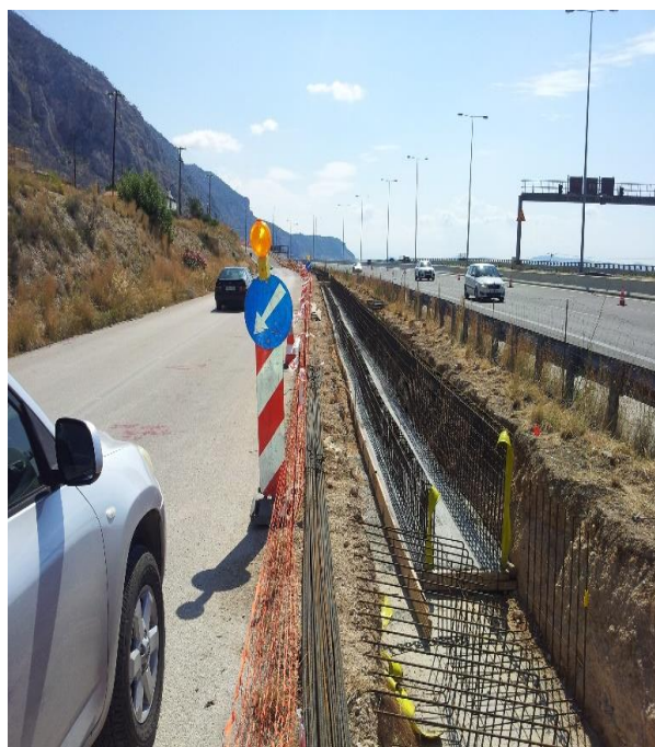
Τοποθέτηση ενίσχυσης σε πλευρικό χαντάκι
