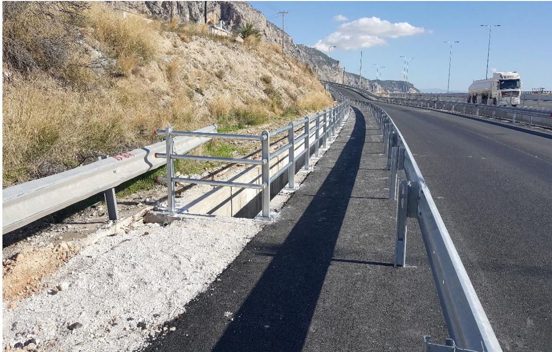
Τοποθέτηση στηθαίων ασφαλείας
