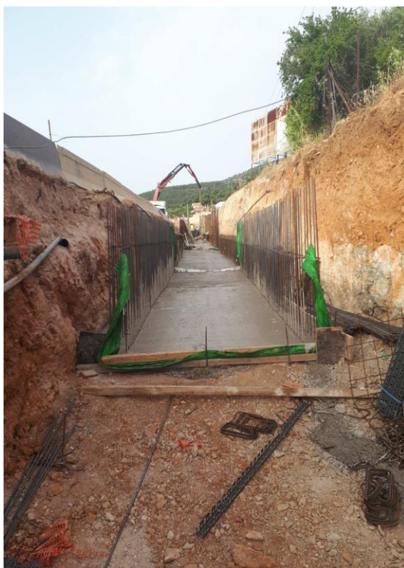
Αντιπλημμυρικά έργα σε τμήμα ΕΛΚΟ (ch. 26+200-26+800)
