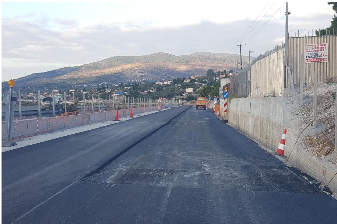
Ολοκλήρωση απόξεσης ασφαλτοτάπητα
