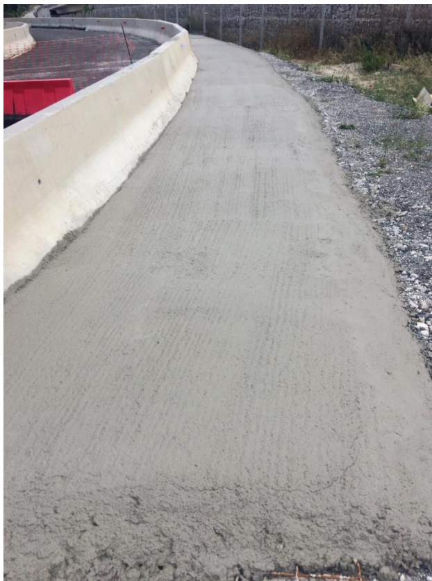
Κατασκευαστικές εργασίες σετον ποταμό Σύθα
