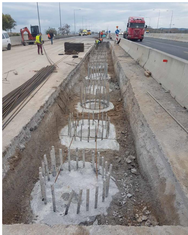
Εργασίες προσωρινής στήριξης σε υφιστάμενα τεχνικά K007-K008
