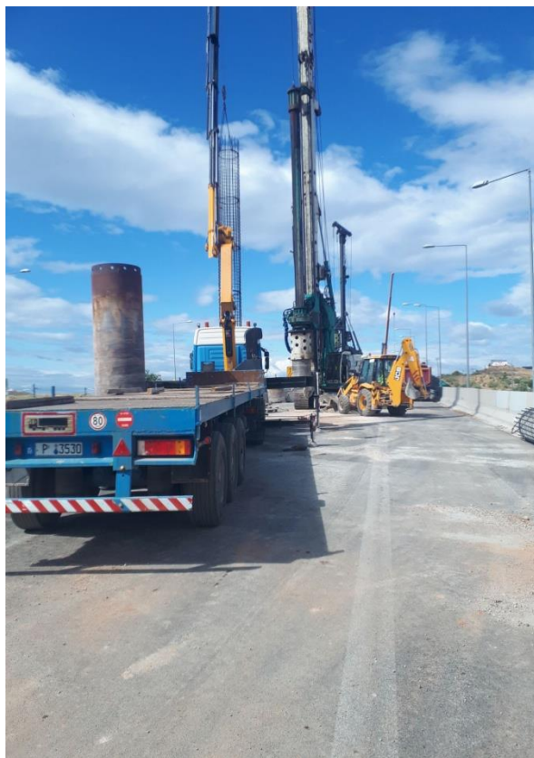
Κατασκευαστικές εργασίες σε υφιστάμενο τεχνικό Κ007-Κ008
