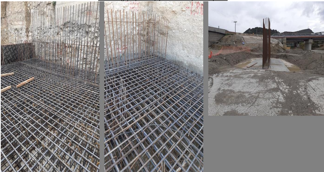
Κατασκευαστικές εργασίες (θεμελίωση) για τη γεφύρωση του ποταμού Σύθα
