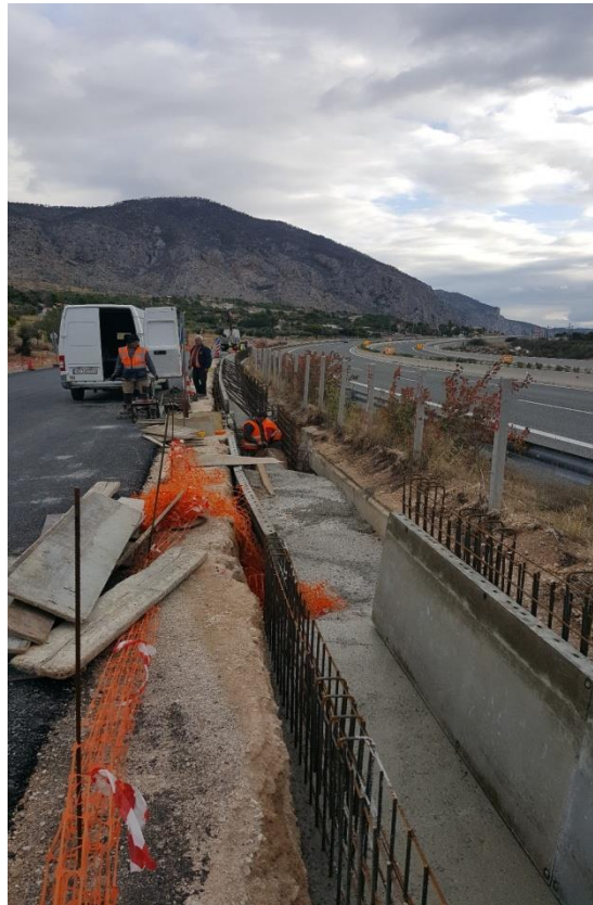
Τοποθέτηση ενίσχυσης σε πλευρικό χαντάκι
