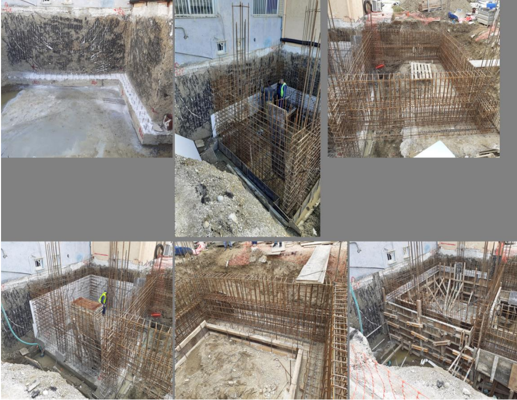
Ανακατασκευή του Κτιρίου Σταθμού Διοδίων Καλαμάκι
